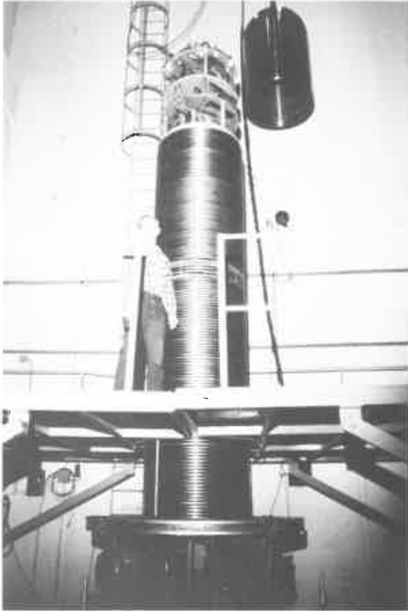
Inside the 6-million volt Van de Graaff accelerator
